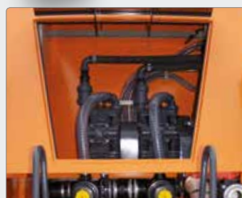
Servicevenligt maskinrum med hurtig adgang til computerenhed, ventiler og væskepumper.
